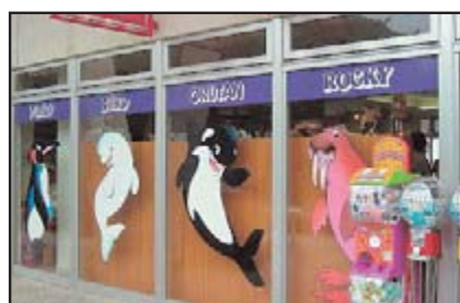
ガラス面への施工
